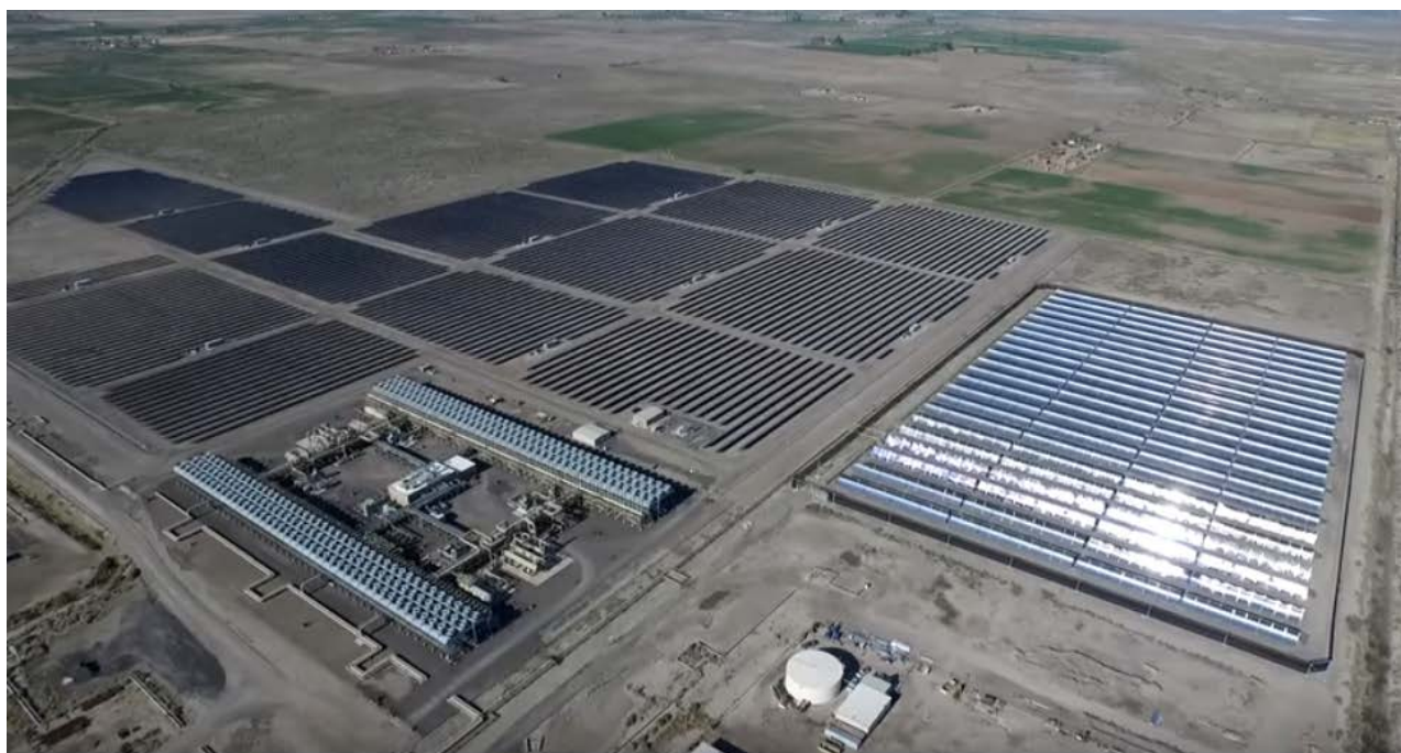
Figura 65 - Vista dell'impianto di Stillwater – ENEL GreenPower
