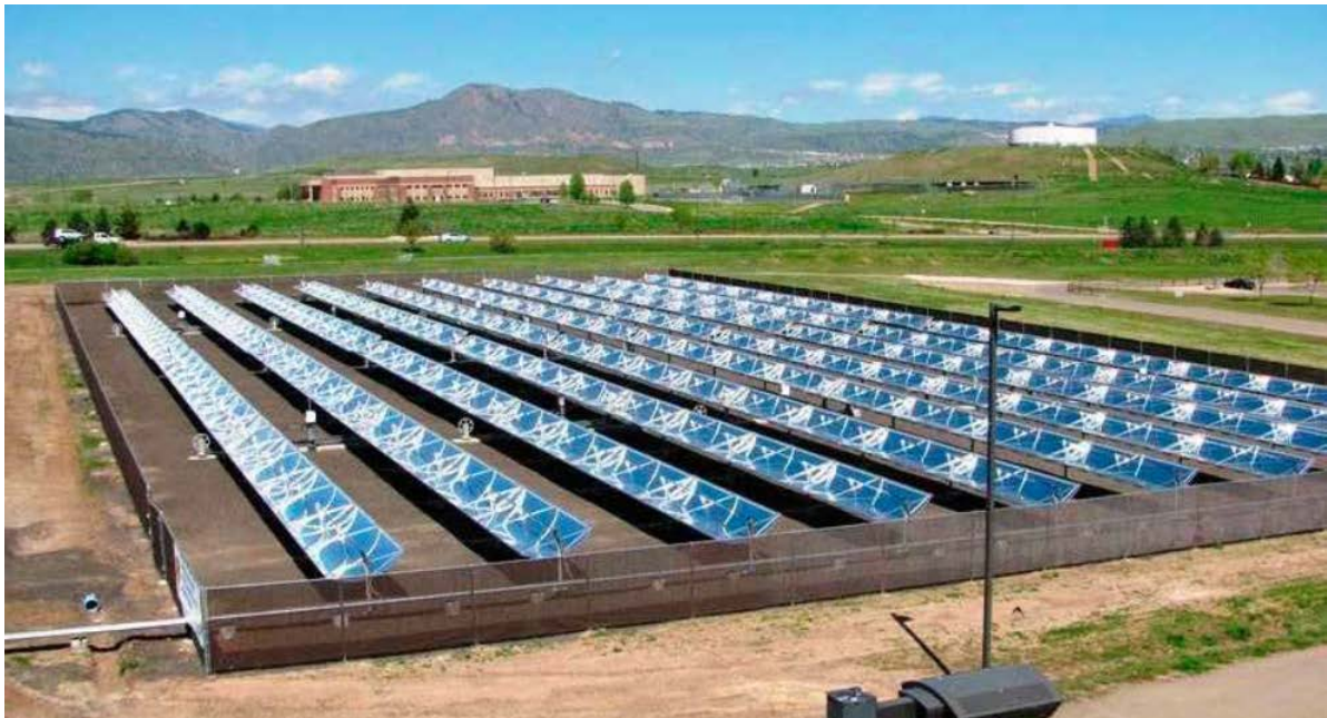
Figura 20 - Impianto di Littleton – Abengoa
